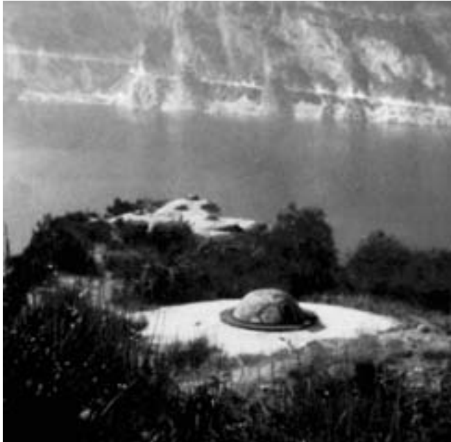
Forte Garda e le sue cupole corazzate girevoli (Museo Storico Italiano della Guerra)
